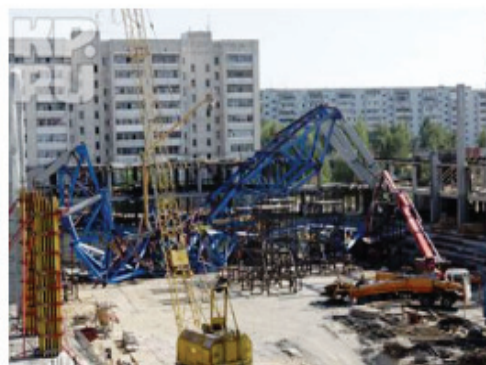
Рисунок 2. Обрушение купола строящегося Центра гимнастики (г. Казань)
