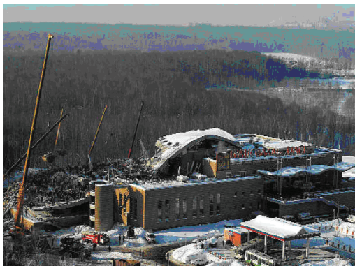
Рисунок 1. Падение купола «Трансвааль Парка» (г. Москва).
