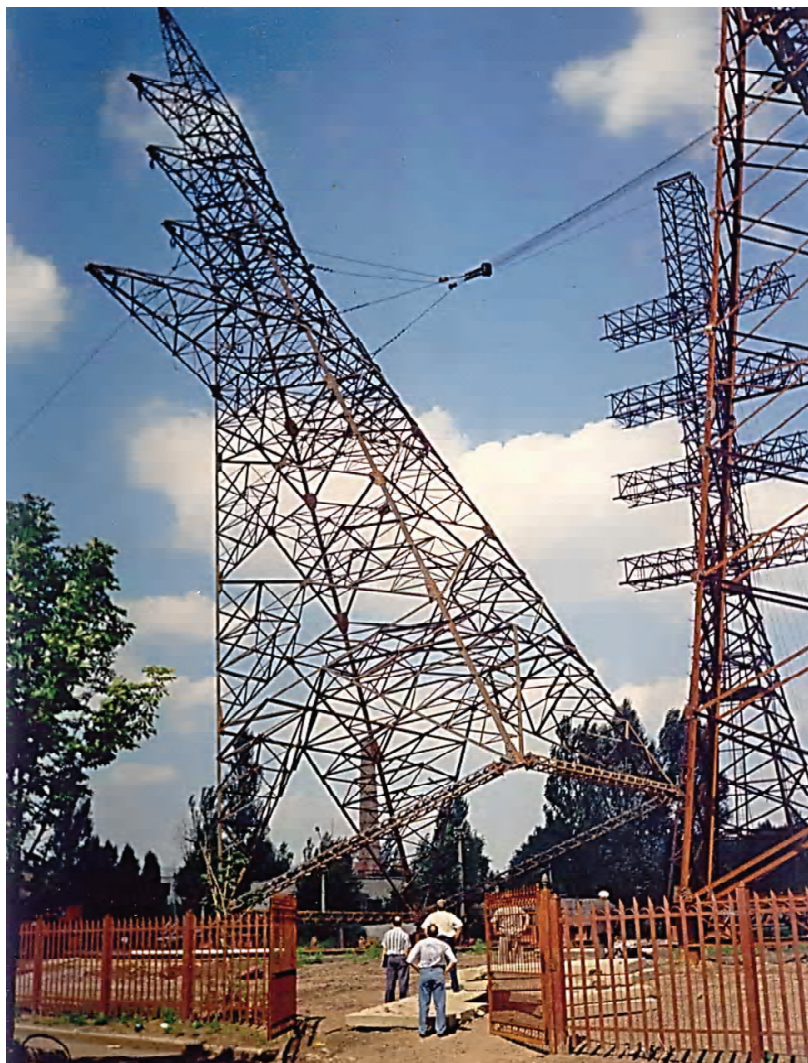
Рисунок 5. Монтаж опоры высотой 62 м и массой 54 т.
