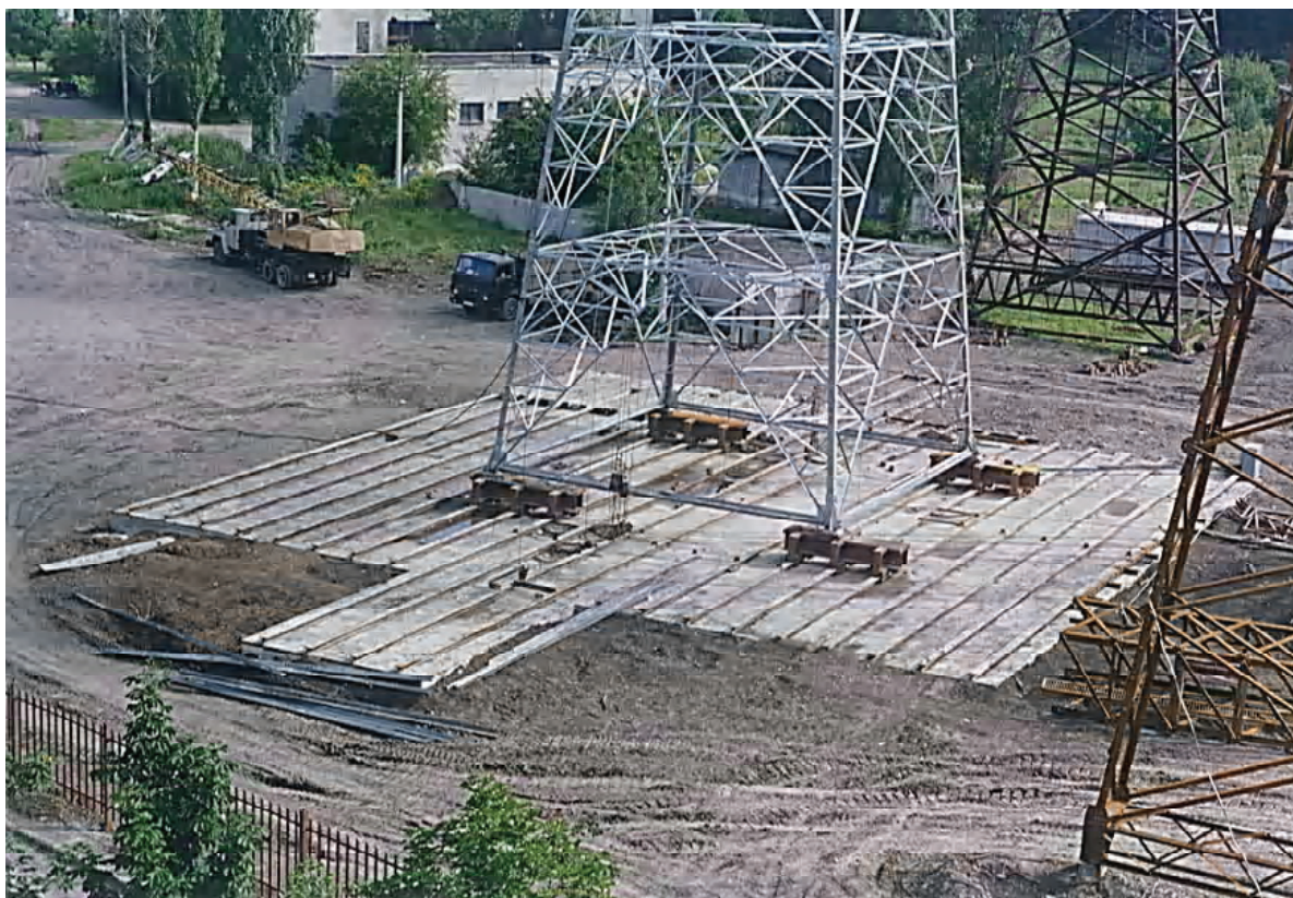
Рисунок 2. Общий вид силового пола с силовыми балками.
