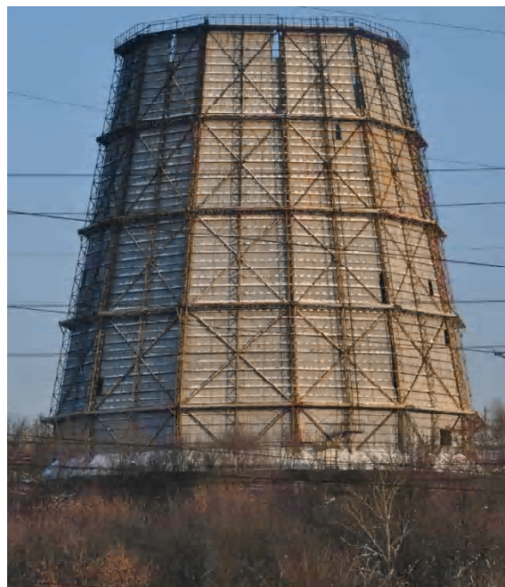
Рисунок 1. Башенная металлическая градирня пирамидальной формы площадью орошения 1 600 м 2 .
