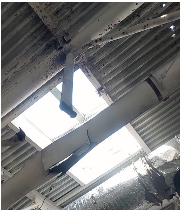
Рисунок 4. Узел нижнего пояса фермы в осях 24/И–Ж: полностью разрушенный элемент нижнего пояса; отрыв стойки от нижнего пояса.
