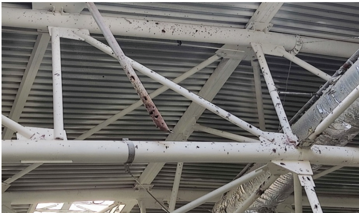
Рисунок 5. Арочная ферма вдоль оси 8, между рядами П–Р: разрушение элемента горизонтальных связей по верхним поясам ферм; осколочные отверстия диаметром до 30 мм в раскосе и подвеске; поверхностные вмятины диаметром до 30 мм в верхнем и нижнем поясе; повреждение защитного покрытия на поясах и решетке арочной фермы.
