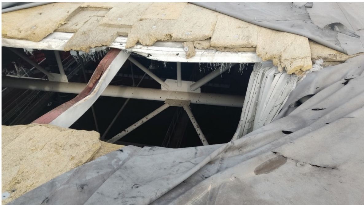
Рисунок 7. Горизонтальные связи по нижним поясам арочных ферм в осях 18–19, между рядами Н–Л. Кровельный прогон между рядами Н–М: множественные осколочные отверстия горизонтальных связей диаметром до 20 мм; множественные поверхностные вмятины горизонтальных связей диаметром до 20 мм; местная деформация кровельного прогона между рядами Н–М; разрушение кровли.
