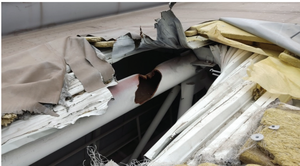
Рисунок 2. Арочная ферма вдоль оси 4/1, между рядами У–Ф: осколочное отверстие размером \varnothing 400 \times 200 мм в верхней поясной трубе; разрушение до 60 % поперечного сечения поясной трубы \varnothing 325 мм; разрушение кровли.
