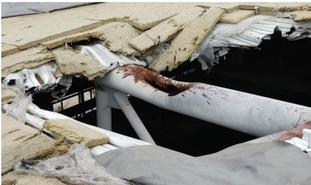
Рисунок 3. Арокная ферма вдоль оси 8, между рядами Е–Ж: осколочное отверстие размером \varnothing 600 \times 200 мм в верхней поясной трубе; разрушение до 50 % поперечного сечения поясной трубы \varnothing 325 мм; повреждение защитного покрытия верхнего пояса с коррозией материала; разрушение кровли.
