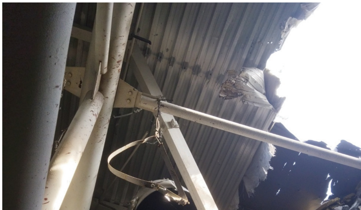
Рисунок 6. Прогон по фонарю. Между рядами У–Ф, оси 14–15: полное разрушение элемента прогона по фонарю.
