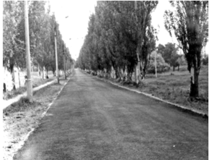
Рис. 8. Участок дорожного покрытия Константиновка-Дзержинск, построенный из влажных шлаковых смесей на кислой смоле сульфатного отделения
