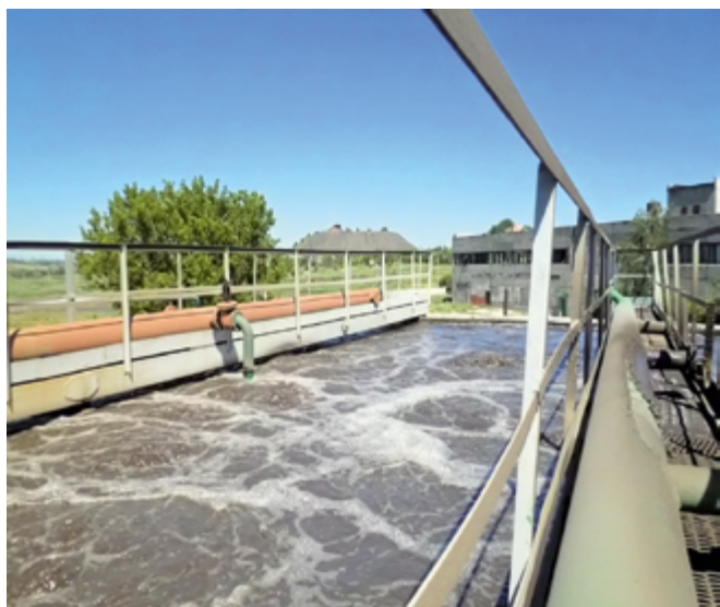
Рис. 6. Биореактор аэробной стабилизации осадков
