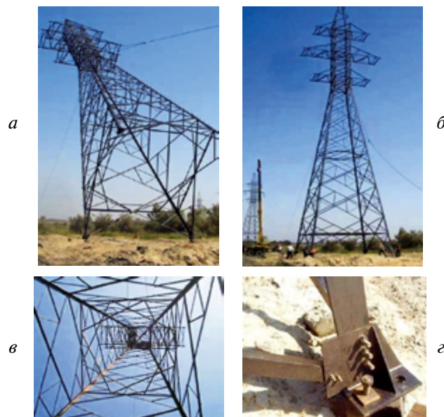
Рис. 4. Оптимальная двухцепная анкерно-уголовая опора У110-2+14: а) опора в процессе монтажа; б) общий вид смонтированной опоры; в) сложная шпренгельная решетка ствола; г) узел крепления опоры к фундаменту (башмак).
