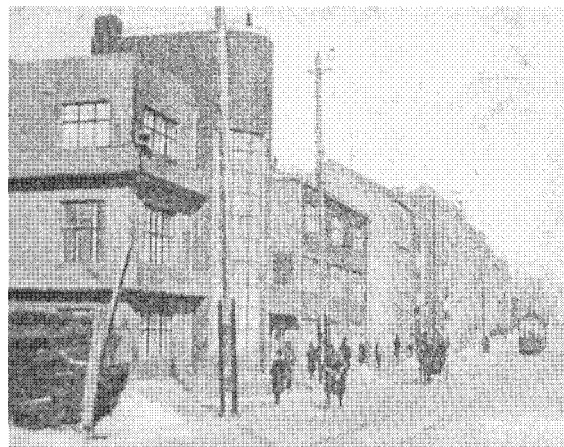
Рис. 4а. Дворец Труда строителей им. Т.Г. Шевченко (снимок 1930 г. до реконструкции)
