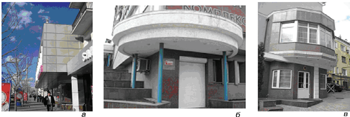
Рис.3. Примеры архитектурных объектов с выраженным нарушением тектонического строя составляющих частей и элементов (а-детский магазин, ул. Артема, б - вход в офис, ул.Набережная, в - вход в офис, Ворошиловский р-н).
