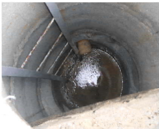
Рис.4. Дренажные колодцы, расположенные на поверхности склона. Апрель 2009-го года.
