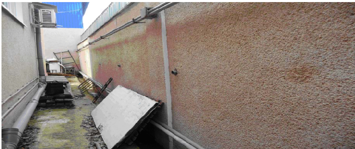
Рис. 2. Подпорная стена, расположенная в нижней зоне склона на территории б.о. «Локомотив». Апрель 2009 года.
