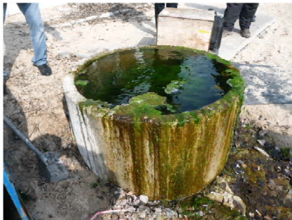
Рис.4. Дренажные колодцы, расположенные на поверхности склона. Апрель 2009-го года.
