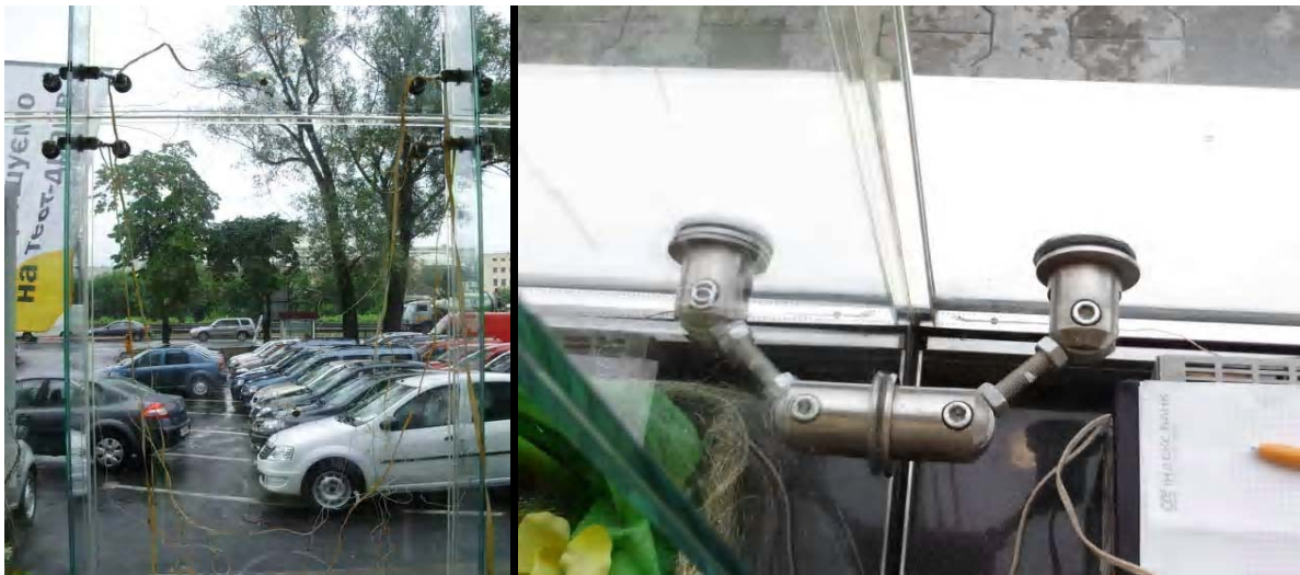
Рис.1. Світлопрозора фасадна система «Spider». Зліва – загальний вид, справа – елементи кріплення.
