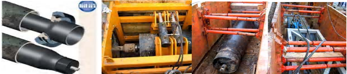
Fig. 7. Method «Swage lining».
