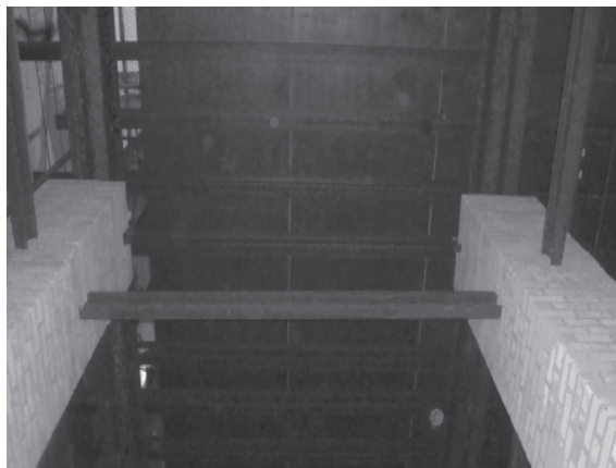
Рис. 1а. Конструкция дна печи.
