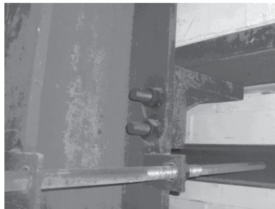
Рис. 1б. Крепление опорного уголка к колонне.
