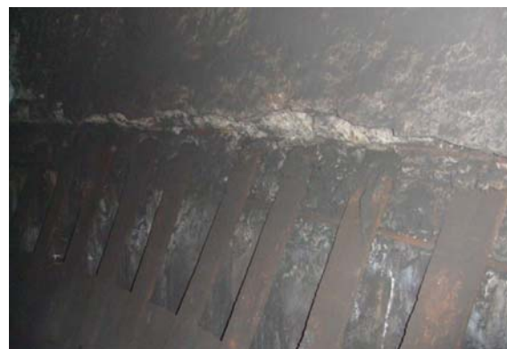
Рис. 2. Крепление воронки к стенке силоса с помощью листовых накладок (языков).
