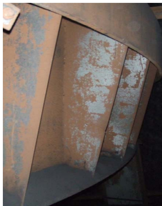
Рис. 7. Кольцевая балка воронки.
