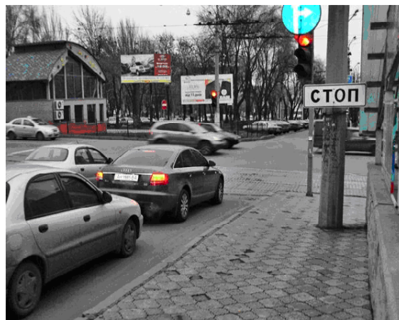
Рис. 2. Пешеходный переход на пересечении ул. Челюскинцев и б-ра Шевченко. Осложнен подход к переходу. Края тротуара не имеют маркировки. Зона перехода слабо выражена, отсутствует светофор с кнопкой вызова. Зона перехода не оборудована пандусными спусками.
