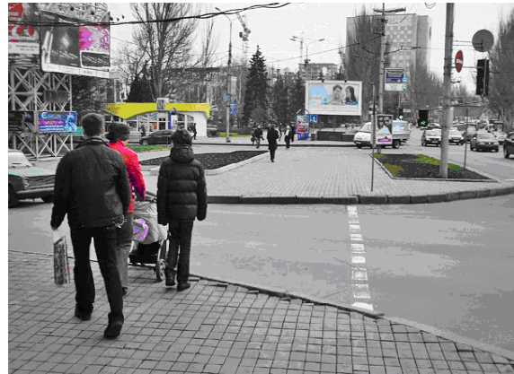
Рис. 4. Пешеходный переход через пр-кт Мира и ул. Артема. Края тротуара не имеют рельефной маркировки, отсутствуют направляющие и ограничивающие турникеты. Зона перехода слабо выражена, отсутствует светофор с кнопкой вызова и пандусные спуски.
