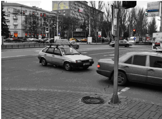
Рис. 3. Пересечение ул. Артема и б-ра Шевченко. Края тротуара не имеют рельефной маркировки. Отсутствует светофор с кнопкой вызова. Зона перехода не оборудована пандусными спусками. Отсутствуют направляющие и ограничивающие турникеты, необходимые для населения с нарушениями зрения, слепых и слабовидящих.
