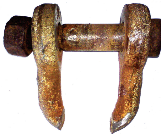
Рис. 7. Разрыв скобы СК-12.1. Опора № 277 ВЛ 330 кВ «Каховская – Джанкой».
