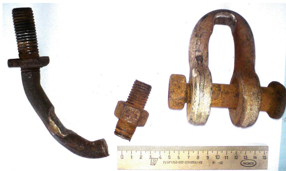
Рис. 3. Разрыв U-образного болта. Опора №299 ВЛ 330 кВ «Каховская – Островская».
