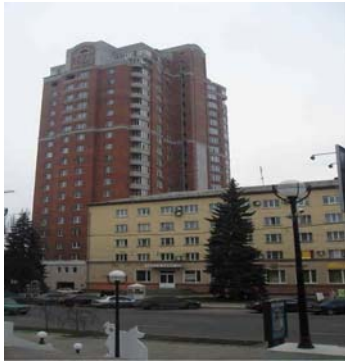
Висотний 19-поверховий житловий будинок по вул. Університетській у центральній частині мікрорайону 21004 Ворошиловського району м. Донецька
