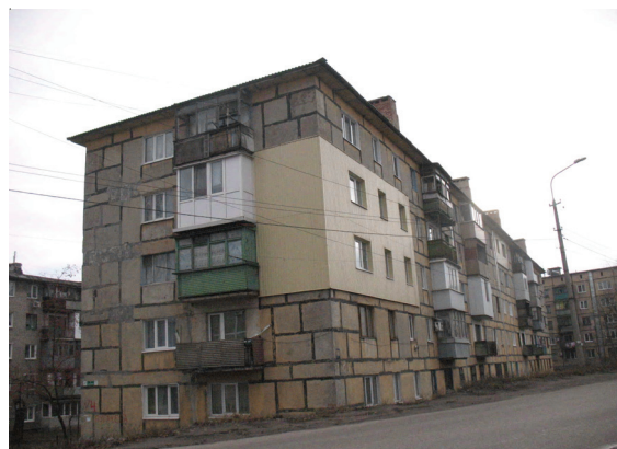
Рисунок 1. Примеры фрагментарного наружного утепления стен в городе Макеевке: а – в одной, б – в двух квартирах.
