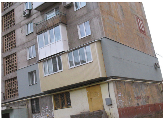
Рисунок 1. Примеры фрагментарного наружного утепления стен в городе Макеевке: а – в одной, б – в двух квартирах.
