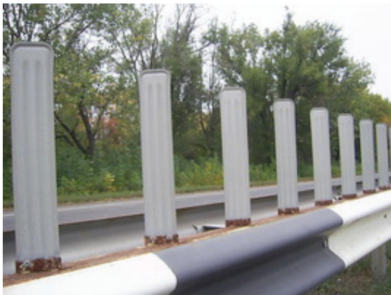
Рисунок 1. Протизасліплювальні екрани на автодорозі Н-21 Старобільськ – Луганськ – Красний Луч – Макіївка – Донецьк.
