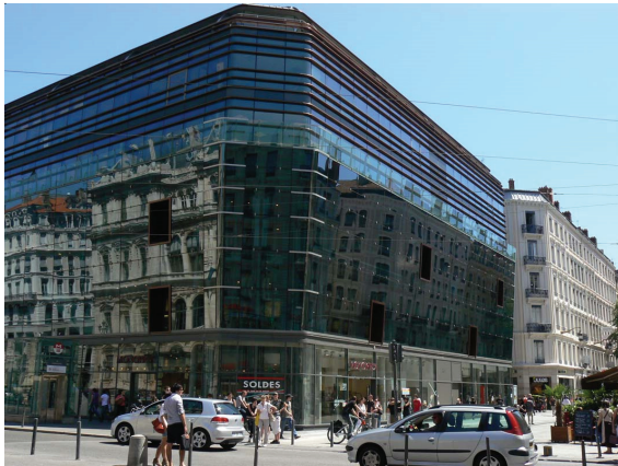
Рисунок 3. Фасад с фотогальваническими модулями компании Faceactive.
