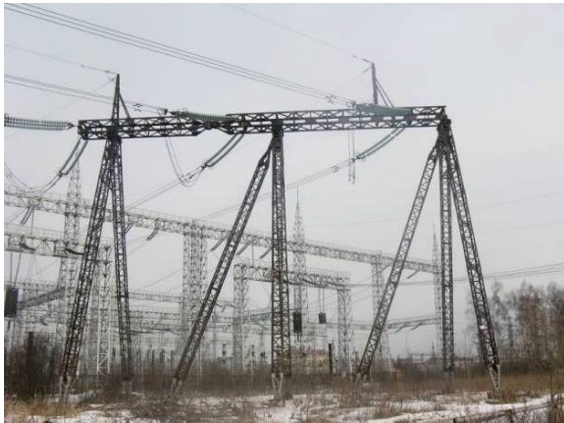
Рисунок 2. Схема порталной опоры ВЛ.
