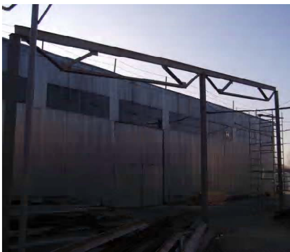
Рисунок 5. Малоелементні комбіновані ферми L = 6, 12 м. Завод «Карпатська кераміка», м. Калуш, Івано-Франківська обл., 2011 р.
