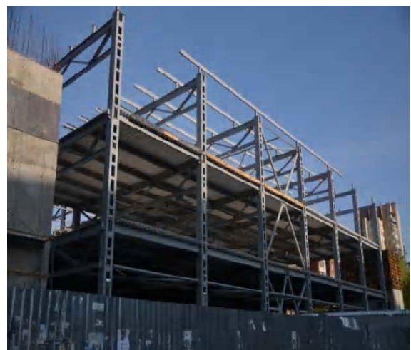
Рисунок 6. Комбіновані ферми покриття, L = 12 і 18 м. Фізкультурно-оздоровчий комплекс, м. Львів, вул. Зубрівська, 2012 р.
