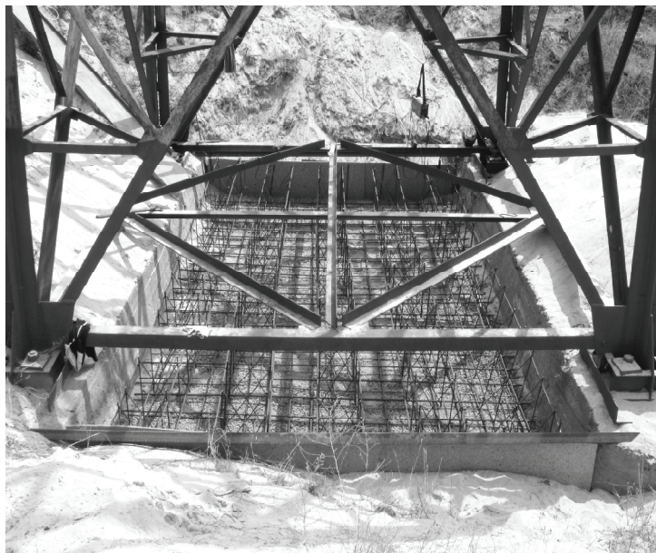
Рисунок 5. Усиление конструкций опор перехода ВЛ: а) увеличение сечения поясов; б), г) усиление фундаментов пригрузочными монолитными ростверками; в) локализация мест щелевой коррозии с обваркой узлов.
