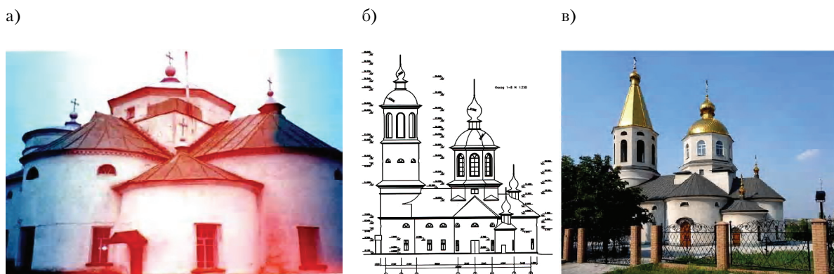
Рисунок 1. Свято-Николаевская церковь в пос. Ясиновка, 1811 г. (г. Макеевка): а) общий вид до восстановления (фото сер. XX в.); б) эскиз фасада в проекте восстановления церкви (2001, канд. арх-ры А. В. Вергелес); в) современный вид (фото 2010-х гг.).
