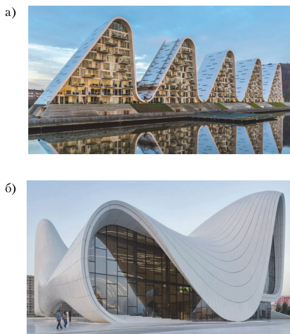
Рисунок 3. Примеры уклона кровельно-фасадных систем (Источник заимствования – ресурсы мировой Сети): а) жилой комплекс Wave, г. Вейле, Дания; б) центр им. Г. Алиева, г. Баку, Азербайджан.
