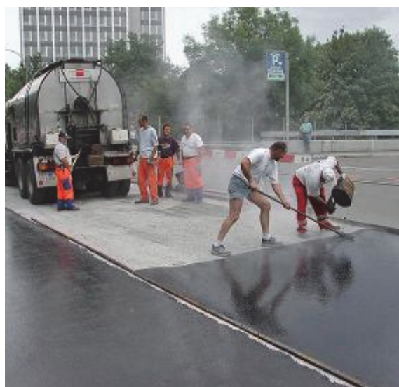
Рисунок 16. Устройство покрытия из литой асфальтобетонной смеси.
