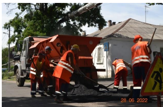
Рисунок 3 - Выполнение работ по текущему ремонту автодорог
