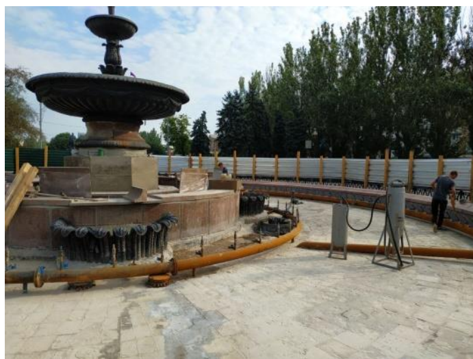
Рисунок 9 - Проведение ремонтных работ (фонтан на пл. Ленина)
