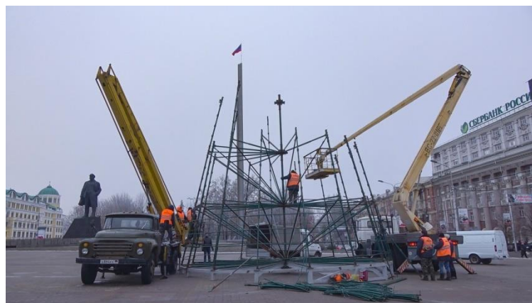
Рисунок 7 - Монтаж конструкции новогодней ели
