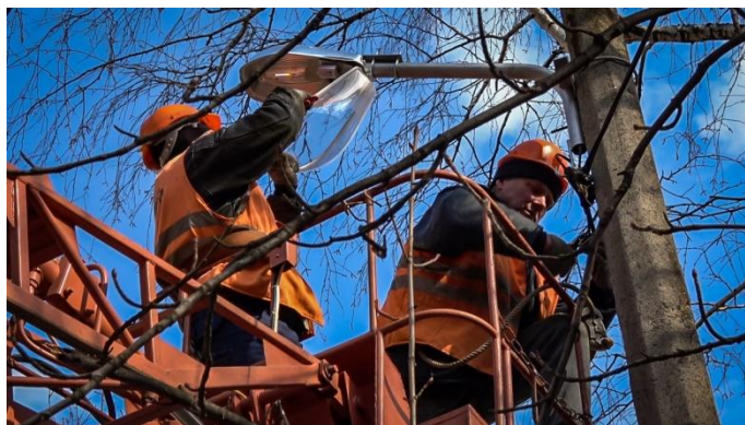
Рисунок 5 - Выполнение работ по текущему обслуживанию
