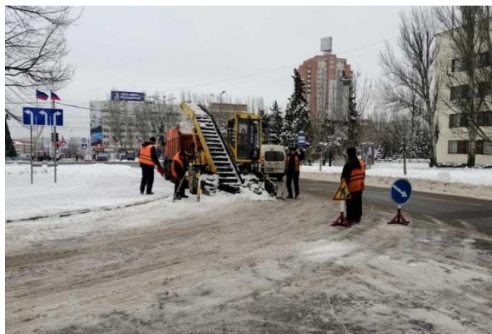
Рисунок 1 - Зимняя уборка проезжей части автодорог
