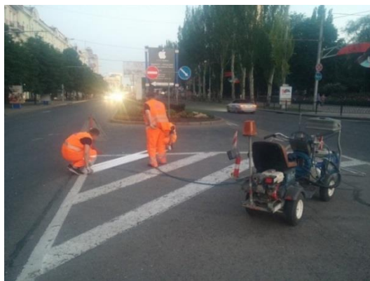
Рисунок 4 - Нанесение линий дорожной разметки
