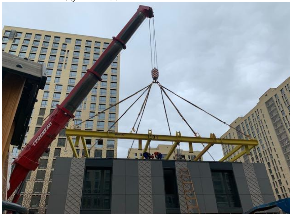
Рис. 2. Сборка здания из сверхкрупногабаритных модулей
