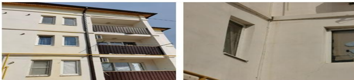
Рисунок 1— Общий вид 3-этажного жилого дома
