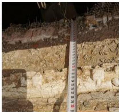
Рисунок 2 — Конструкция стены из несъемной опалубки из пенополистирола
