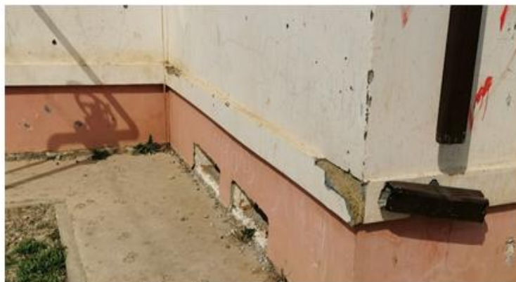
Рисунок 3 — Устройство шва междуэтажных перекрытий здания
