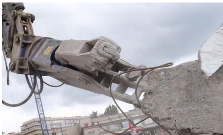
Рисунок 3 — Разрушение железобетона гидроразрушителями
