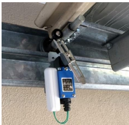
Рисунок 1. Пример использования механического датчика-концевика
