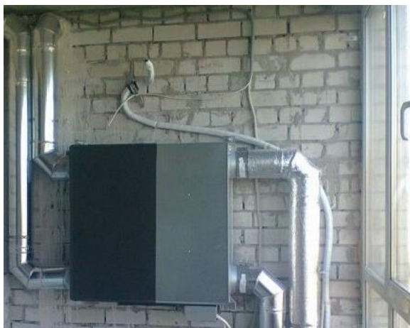
Рисунок 2. Механическая вентиляция в паре с воздушным отоплением
