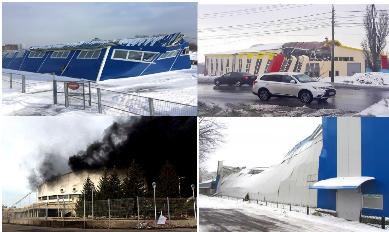
Рисунок 2 – Последствия аварийных отказов строительных конструкций и систем
