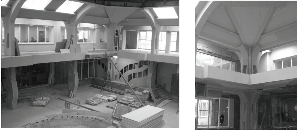
Фото 2 – Реконструкция рекреационной зоны главного учебного корпуса ДонНАСА.
