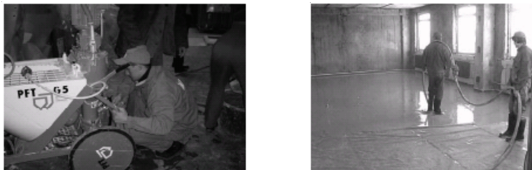
Рисунок 2 – Подготовка машин Кнауф-ПФТ и процесс заливки гипсового пола.
