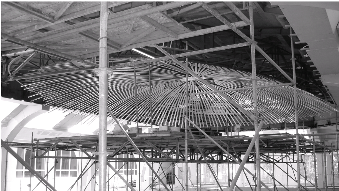
Фото 3 – Монтаж вспомогательного каркаса из гнутых СД профилей Кнауф.
