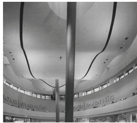
Фото 1 – Примеры дизайнерского решения криволинейных гипсокартонных потолков.
