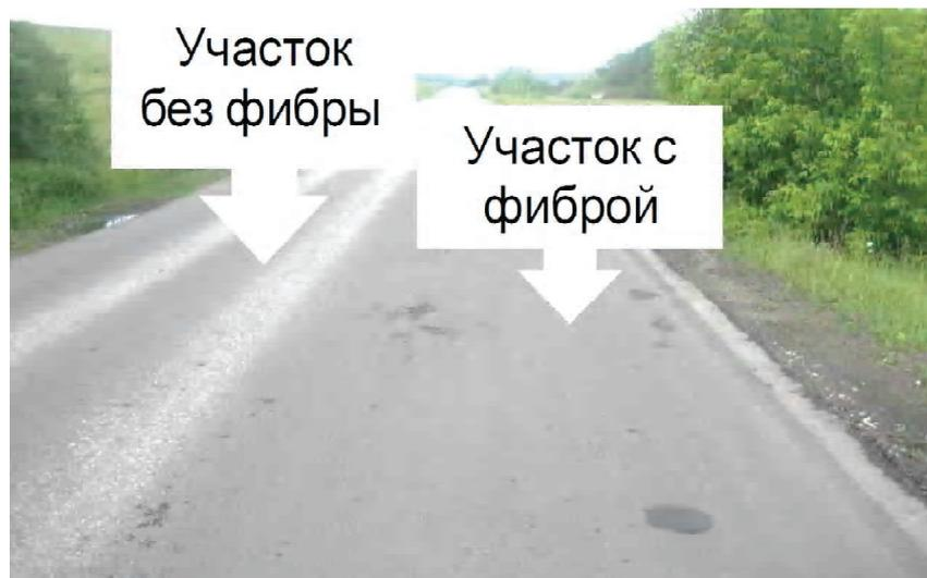
**Рисунок 1** – Сравнение состояния участка автомобильной дороги с фиброасфальтобетоном и традиционным асфальтобетонным покрытием.
