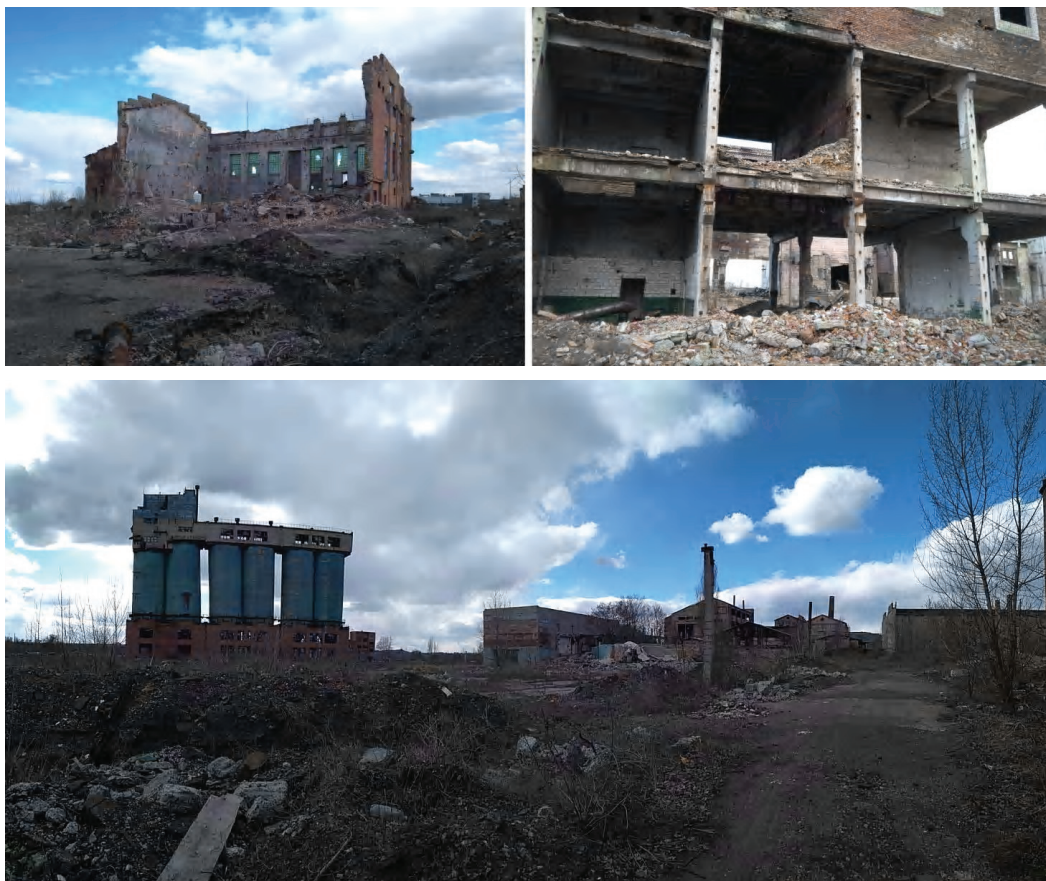
Рисунок 2 – Состояние зданий ДКХЗ в настоящее время.
