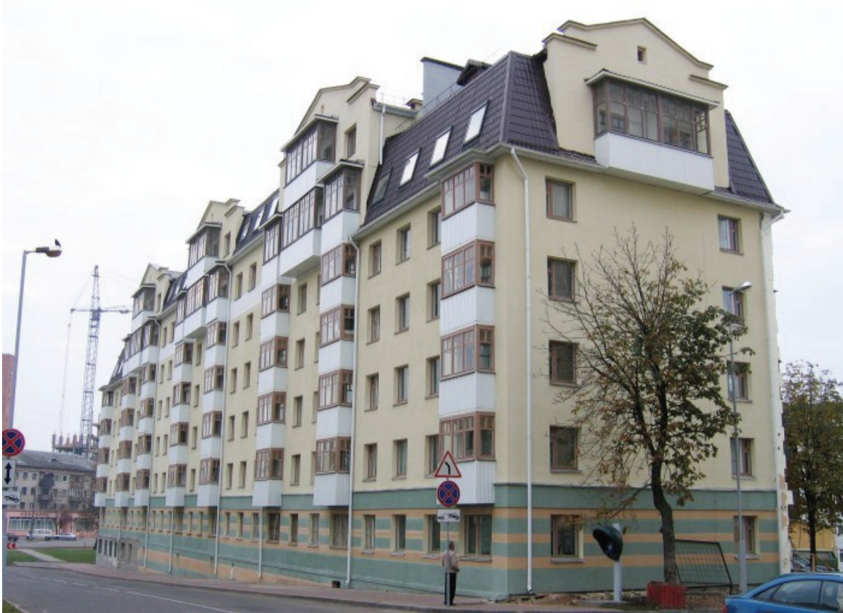
Рисунок 2 – Пример реконструкции существующего типового 5-этажного жилого дома с надстройкой дополнительного мансардного этажа в городе Минск, Белоруссия.
