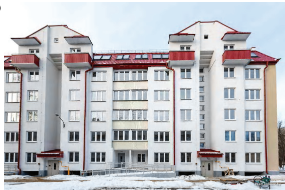
Рисунок 3 – Пример реконструкции существующего типового 5-этажного жилого дома с надстройкой дополнительного мансардного этажа и пристройкой эркеров в городе Минск, Белоруссия: а) фрагмент объемно-пространственного решения жилого дома после реконструкции; б) главный фасад жилого дома после реконструкции.
