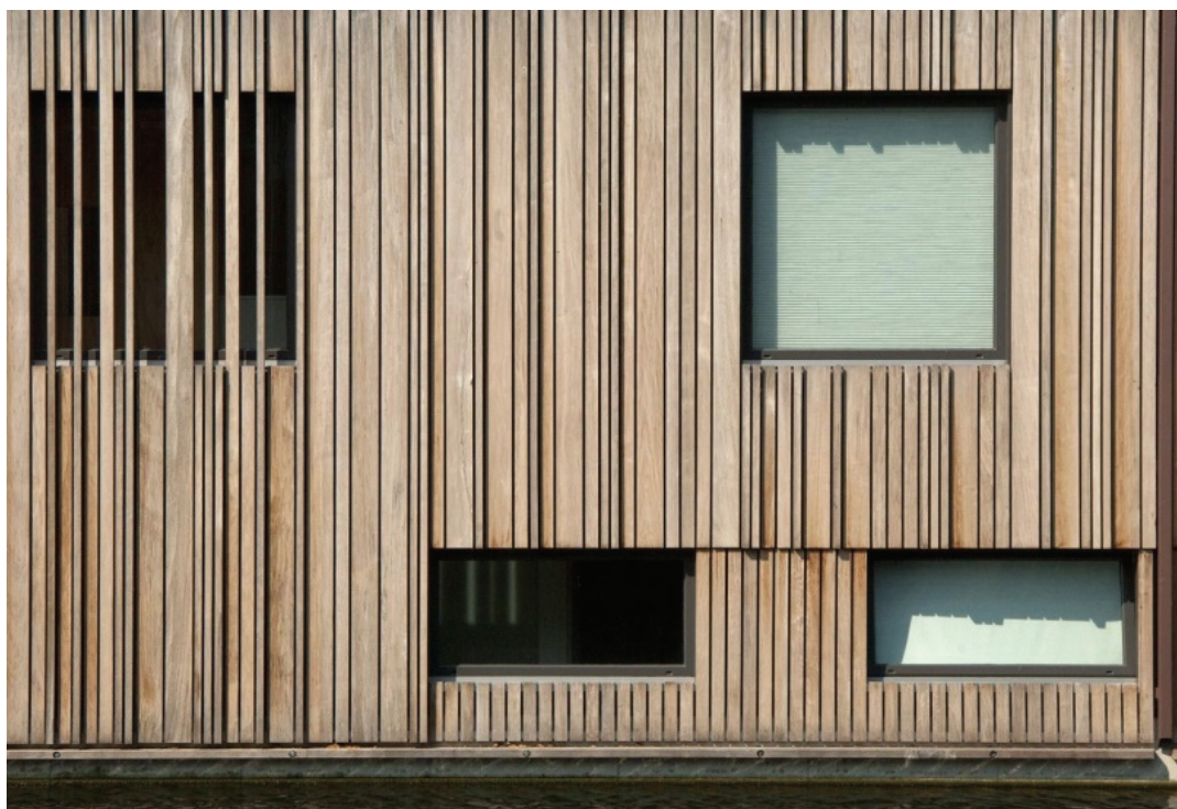
Рисунок 1 – Пример применения навесного фасада выполненного из дерева.
