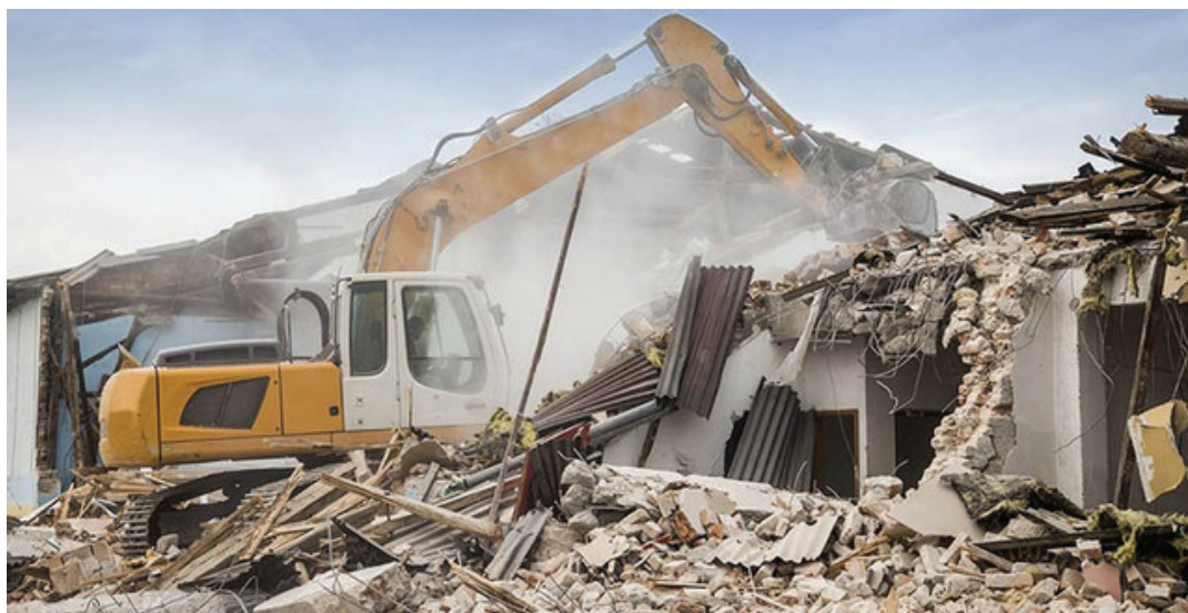
Рисунок – Снос ветхого жилого здания.
