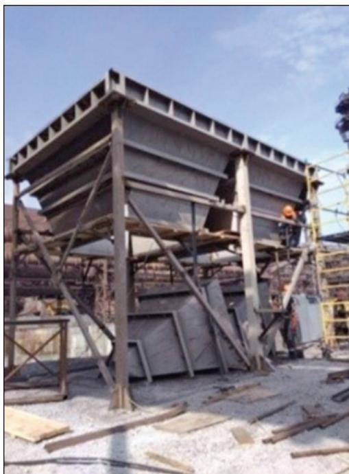
**Рисунок 5** – Укрупнительная сборка на стенде опорного пояса с бункерами.
