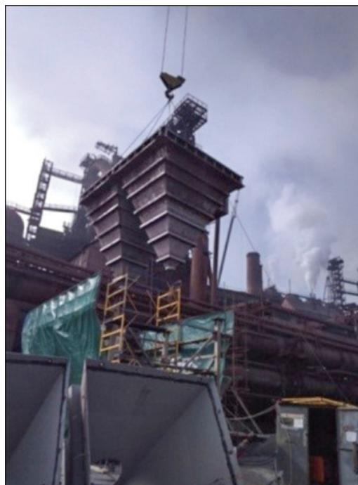
**Рисунок 6** – Монтаж м/к блоков опорного пояса с бункерами.
