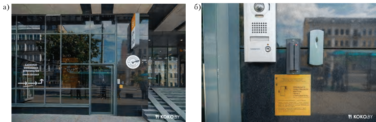
Рисунок 2 – Первая в Беларуси кофейня для лиц с ограничениями здоровья «Инклюзивный бариста»: а) вход в здание, организованный с отсутствием перепадов высот, б) пример использования технологий, с помощью которых человек с инвалидностью может получить помощь сотрудников).
