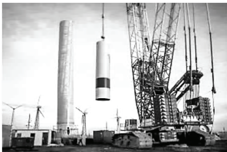
Рисунок 3 – Монтаж ветрогенератора с помощью монтажного крана.
