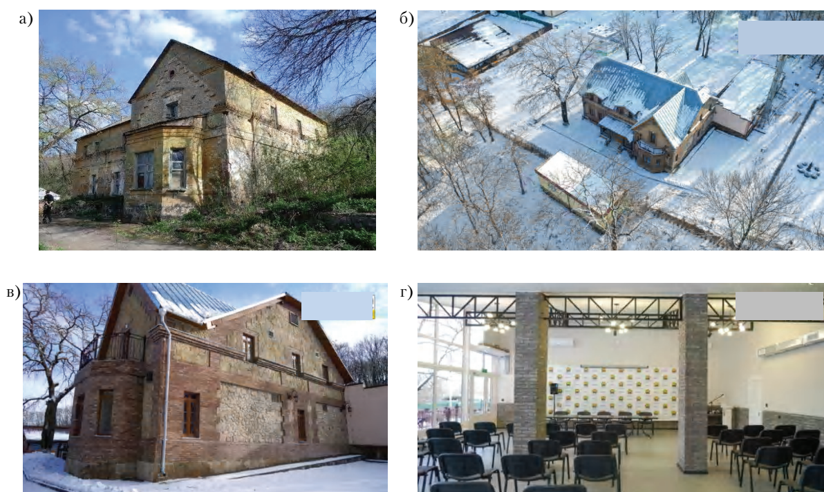
Рисунок 6 – Усадьба В. А. Бантыша в пгт Камышеваха г. Краматорска – состояние усадьбы до реконструкции 2019 г.: а) общий вид дома; б) общий вид усадьбы; в) общий вид дома после реконструкции; г) общий вид пристроенного зала заседаний.
