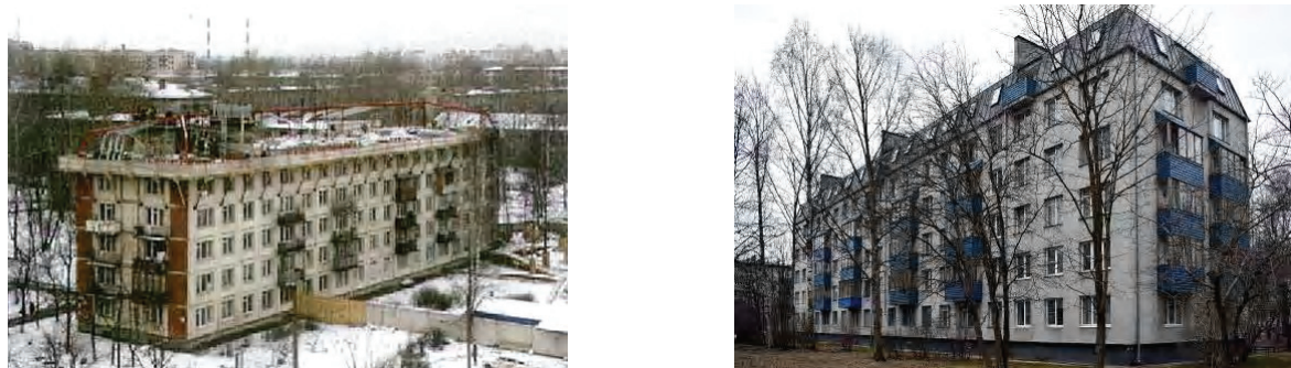
Рисунок 4, 5 – Дом на Торжковской улице СПб во время и после реконструкции [5].
