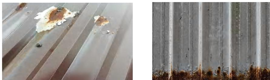
**Рисунок 3** – Коррозионный износ стального профиля.
