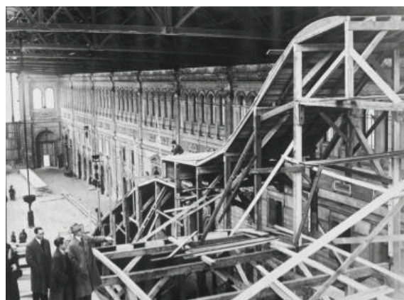
Рисунок 2 – Строительство трамплина.
