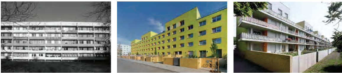
Рисунок 1 – г. Галл. Здание советского периода до и после реконструкции [3].
