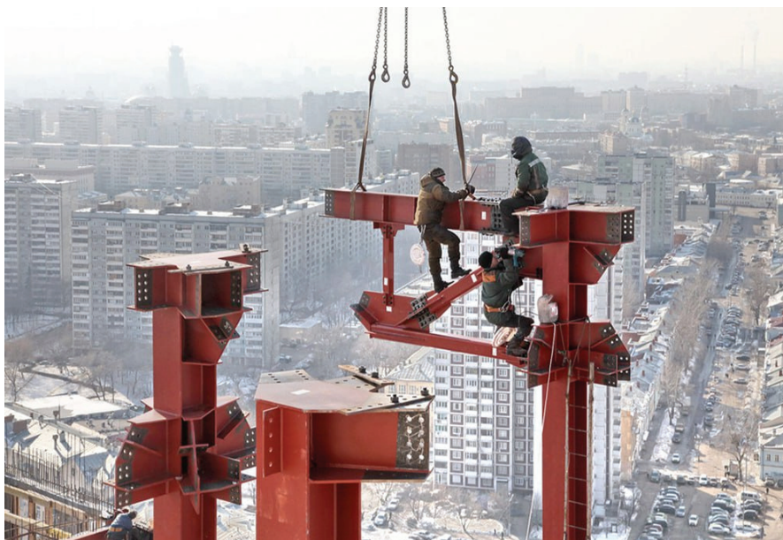
Рисунок 2 – Крупноблочный монтаж металлических конструкций.
