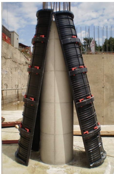
Рисунок 8 – Пластмассовая сборно-разборная опалубка круглых колонн.
