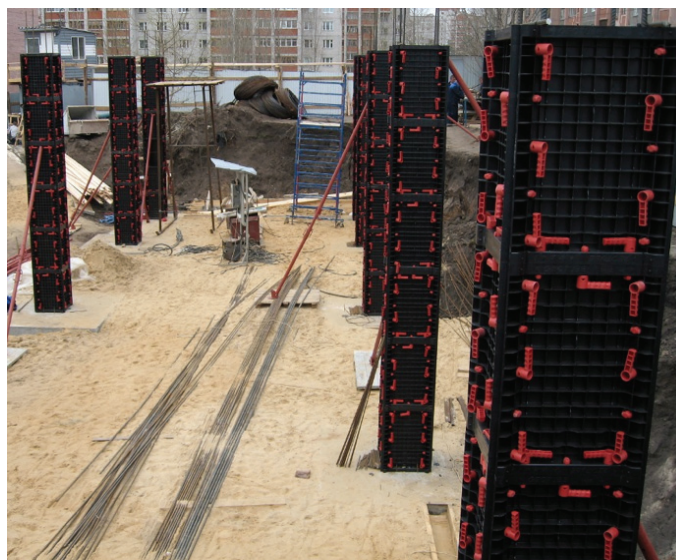
Рисунок 9 – Пластмассовая сборно-разборная квадратного сечения колонн.
