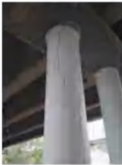
Трещины в теле бетона
