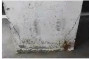
Трещины в основании
