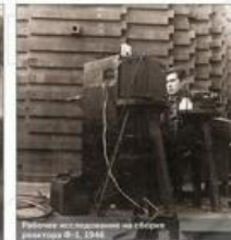
Работы по обслуживанию на объекте реактора Ф-2, 1946
