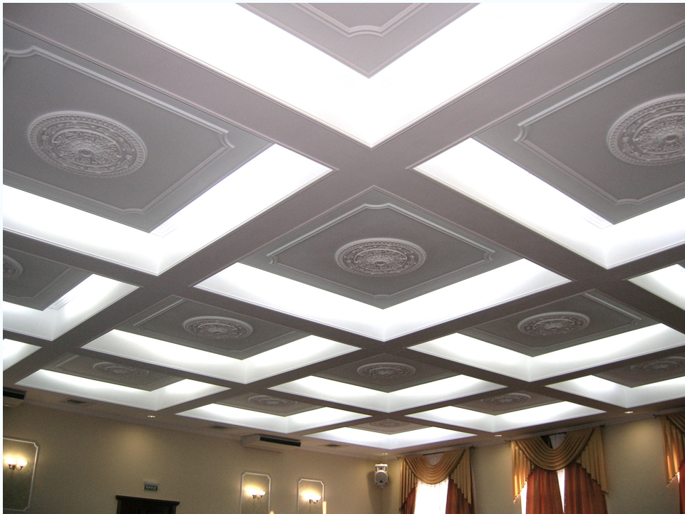
Донецкий центр медицины катастроф. Актный зал . Потолок кессонной системы из гипсокартона
