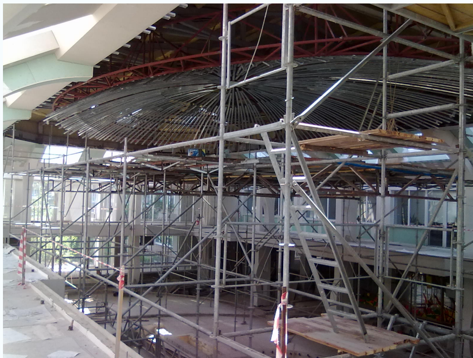
Монтаж оболочки размером 16,3х9,6м в рекреационной зоне главного корпуса ДонНАСА
