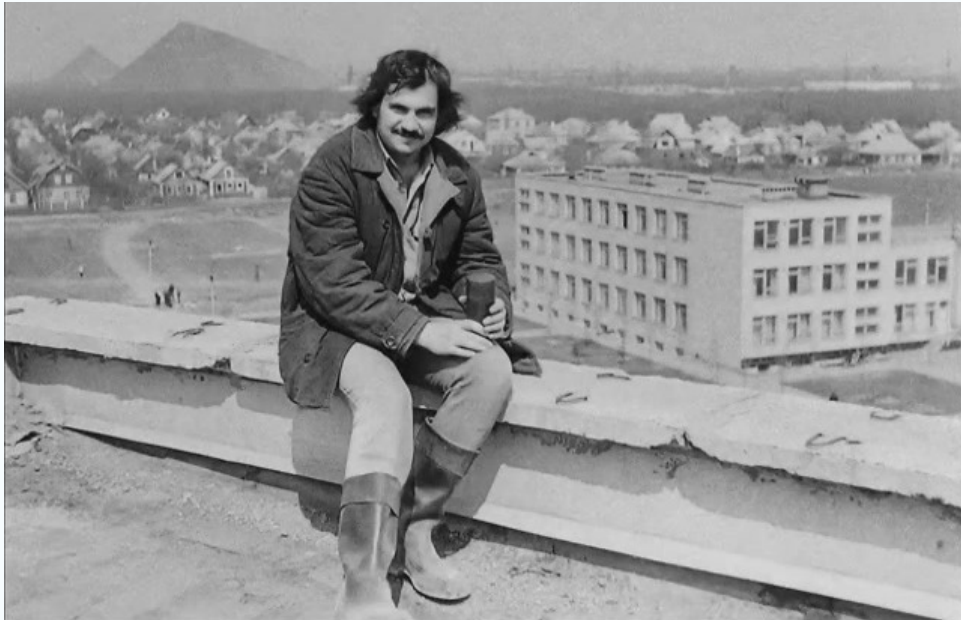
На крыше строящегося корпуса №1, Алексеев Б.А., 1976 г.
