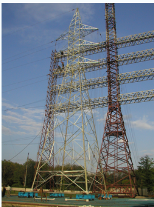
На фото: испытание на Полигоне уникальной опоры ЛЭП для Египта высотой 64 м.
