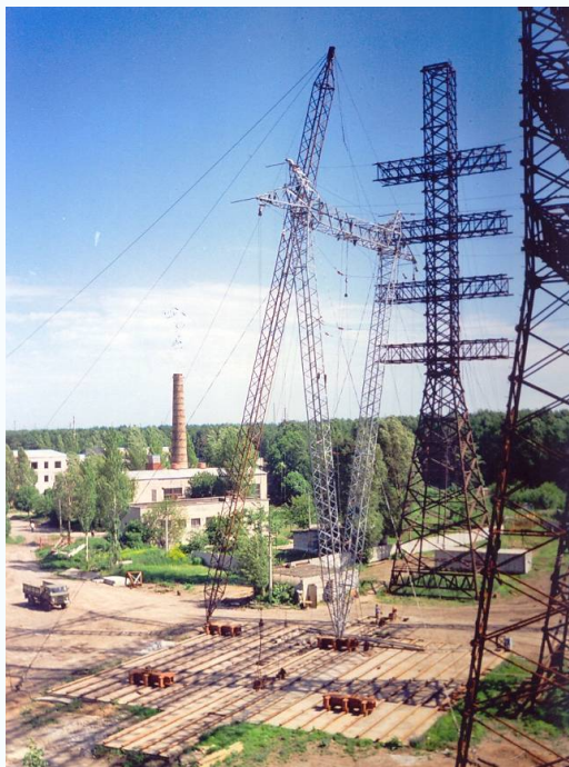
На фото: испытания V-образной опоры на оттяжках для Исландии
