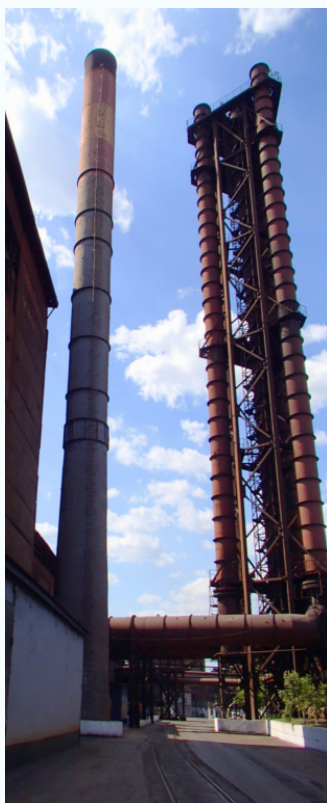
Дымовая труба и вытяжная башня
